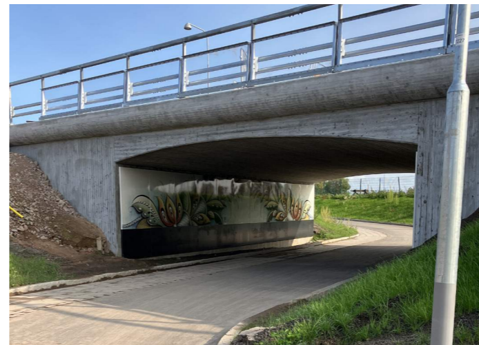
Ny GC-tunnel under väg E45 förbättrar tillgängligheten till Mora centralstation.
